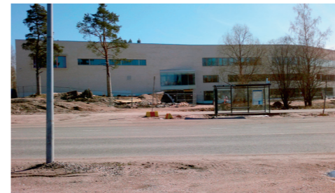
Mårtensbron koulu on yksi RAILO-hankkeen pilottikohteista. Koulurakennukseen on asennettu useita kosteutta mittaavia antureita, joiden avulla kerätään tietoa rakenteiden kunnosta.
